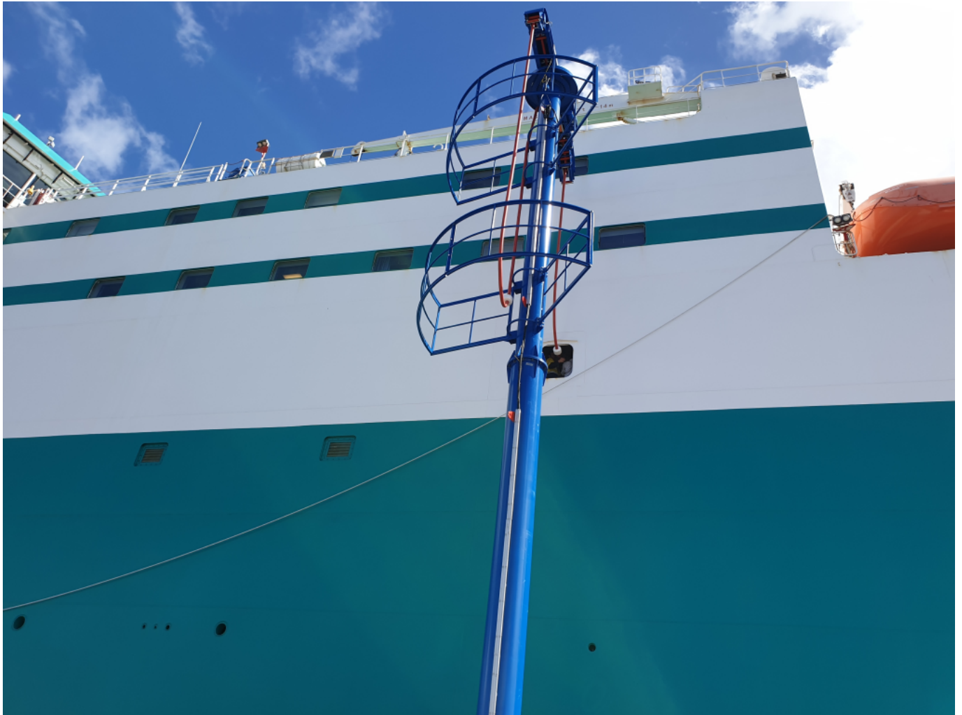
A kábelcsatlakozó beemelése a hajóba
