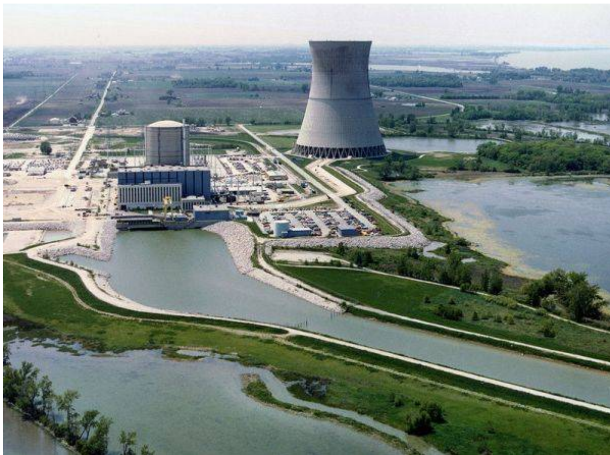
Davis-Besse atomerőmű, Ohio
